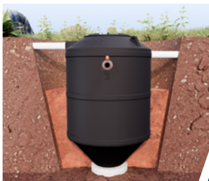
Figura 9 - Aterro completo com compactação.
